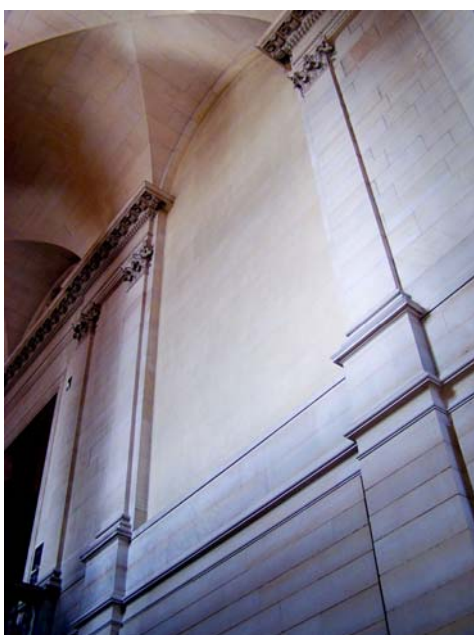
Palier de l'escalier nord de la Colonnade, aile Sully © Musée du Louvre/Antoine Mongodin
