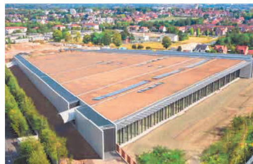
Centre de conservation du Louvre © Architecte Rogers Stirk Harbour + Partners / Paysagiste Mutabilis Paysage et Urbanisme / Joas Souza Photographe
