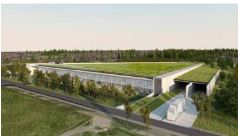
Centre de conservation du musée du Louvre à Liévin. Vue d'ensemble du projet. © Rogers Stirk Harbour + Partners
