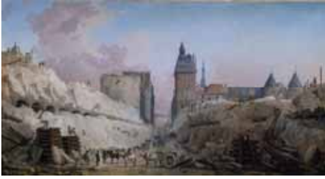
Hubert Robert. La Démolition des maisons du pont au Change . Paris, musée Carnavalet © Musée Carnavalet / Roger-Viollet
